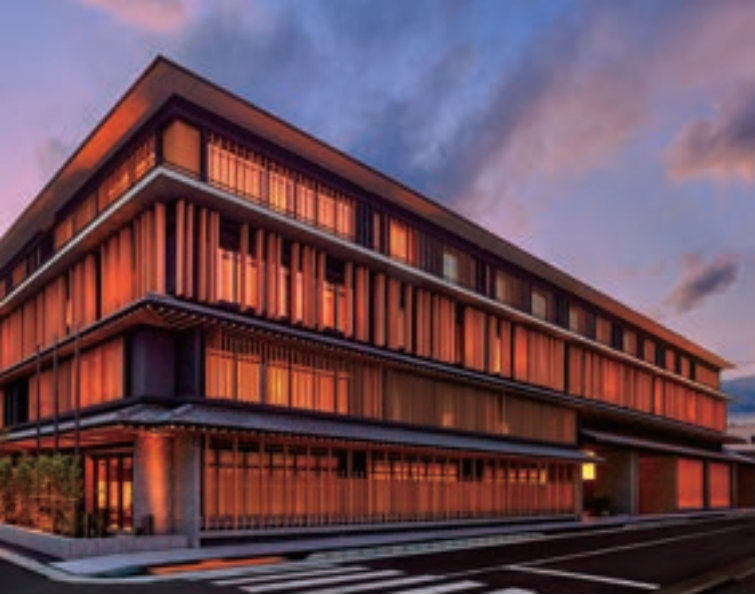
屋根や庇、木のルーバーが特徴的な外観
