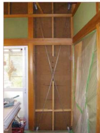
なげしを壊さず施工(真壁)
