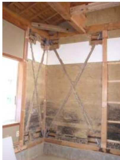
土壁を残して(一間)
