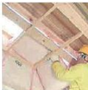
② 野縁の上にアクリアマットを敷き込みます。
