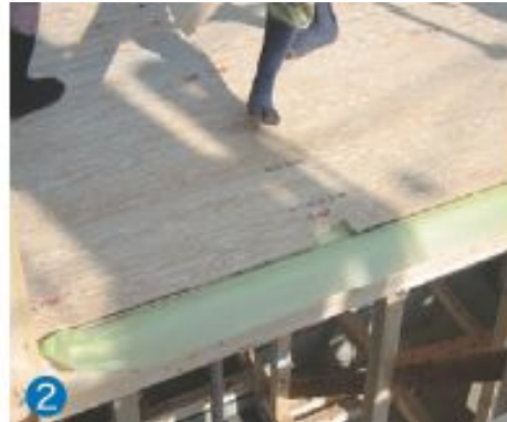
② 防湿シートを床下地材で押さえ付けます。
