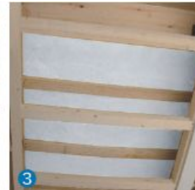
③ 下からアクリアUボードを施工します。
