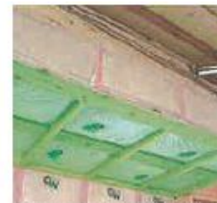
⑥ 天井部分に防湿シートを施工します。(写真の防湿シートは合成です)
