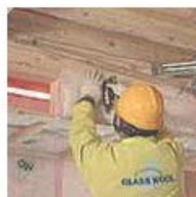
④ 下がり壁部分にも寸法に合わせてカットしたアクリアマットを充填します。
