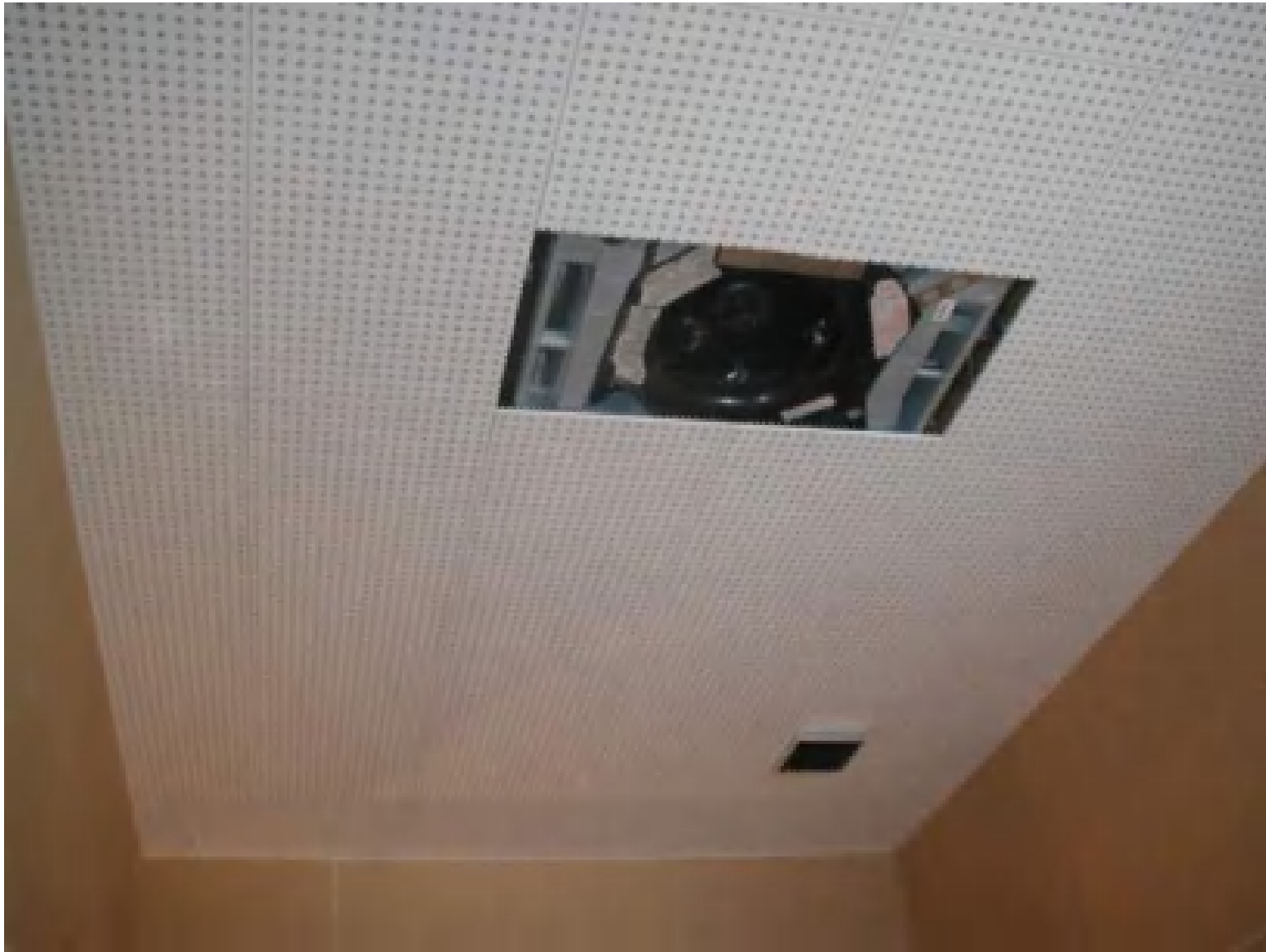
東京都 新宿区のビル改修工事(エントランスホール等)
