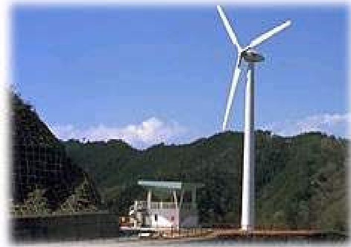
風力発電設備(奥多々良木発電所)
