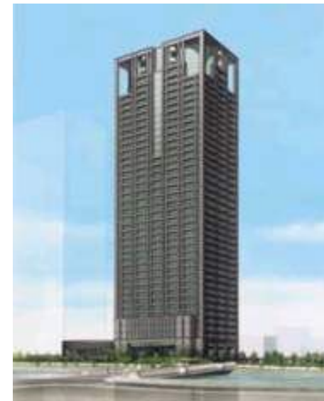
合計出力100kWの太陽光発電設備を導入(新関電ビル)
