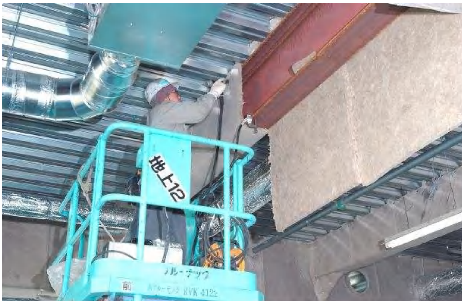
粉塵の無い作業環境で施工中
